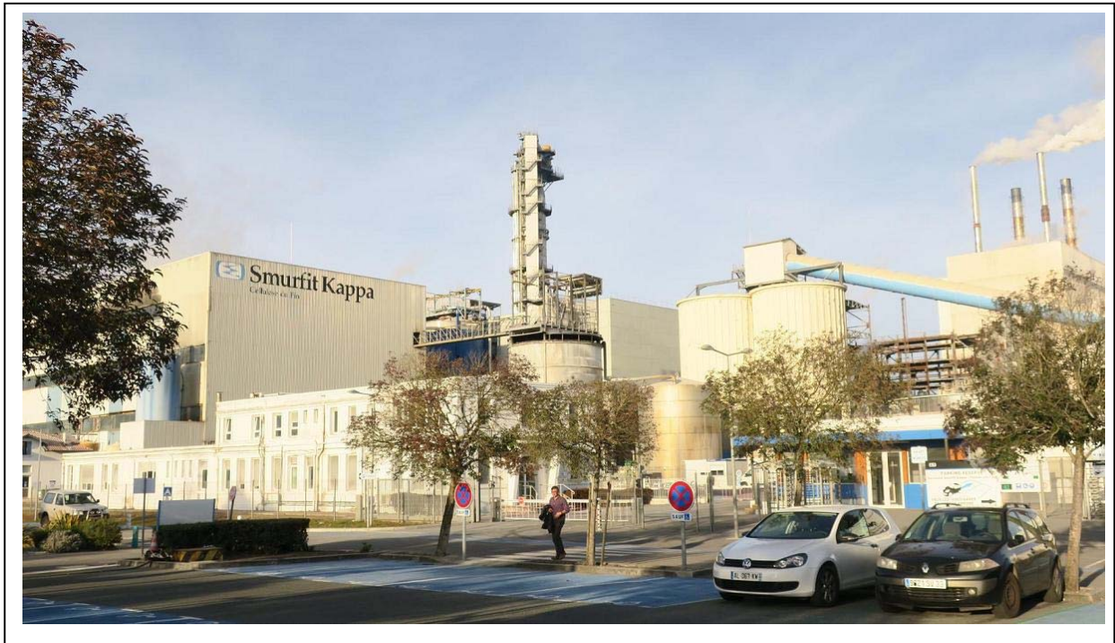
Papeterie Smurfit Kappa de Facture – entrée de l'usine (au centre, vertical, le " lessiveur ")
